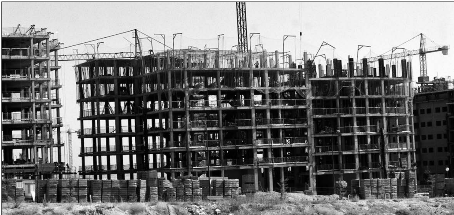
Viviendas en construcción.
