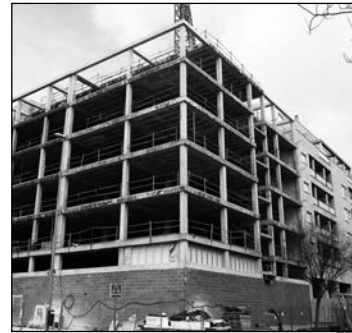
Viviendas en construcción.
