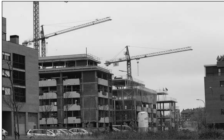
Construcción de viviendas en Madrid.
