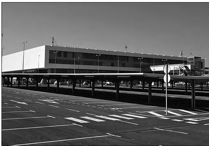
Vista del aeropuerto de Ciudad Real, cerrado desde 2012.
