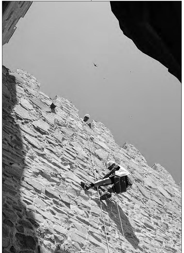
Técnico instalando sensores en la muralla abulense.
