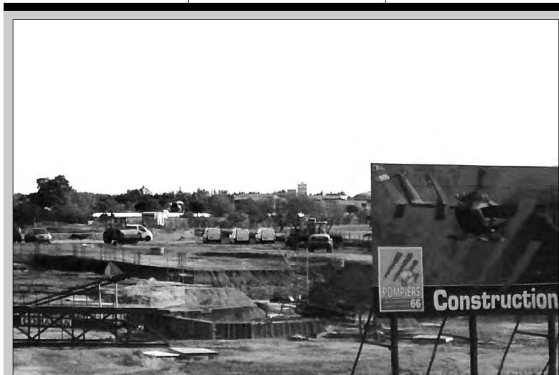
Obras del Centro de Emergencias de Perpiñán a cargo de la constructora española Urcotex.
