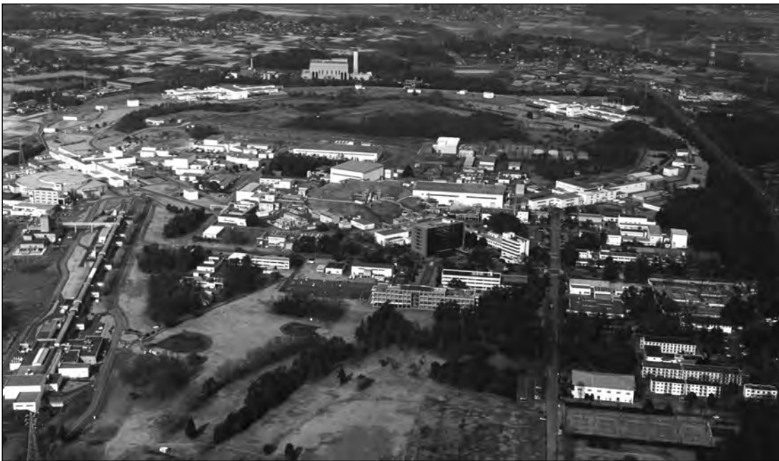
Instalaciones en las que operará el acelerador de partículas SuperKEKB.
