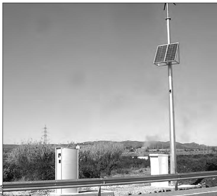
Indra ha desarrollado un sistema híbrido solar-eólico para la alimentación de equipos de seguridad vial.
