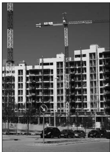
Construcción de viviendas en Madrid.
