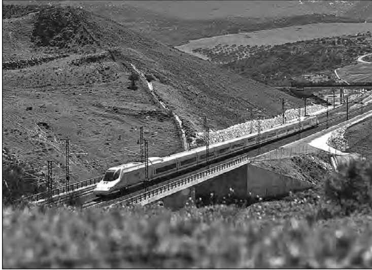
Las obras del AVE siguen siendo el puntal de la inversión en infraestructuras. EP
