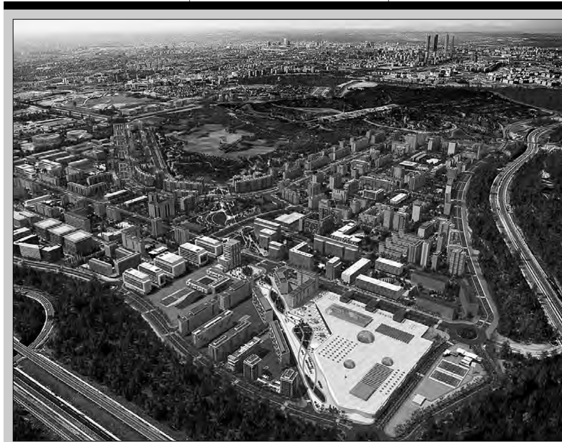
Proyecto urbanístico de Valdebebas, ubicado junto a Ifema, en el nordeste de Madrid.
