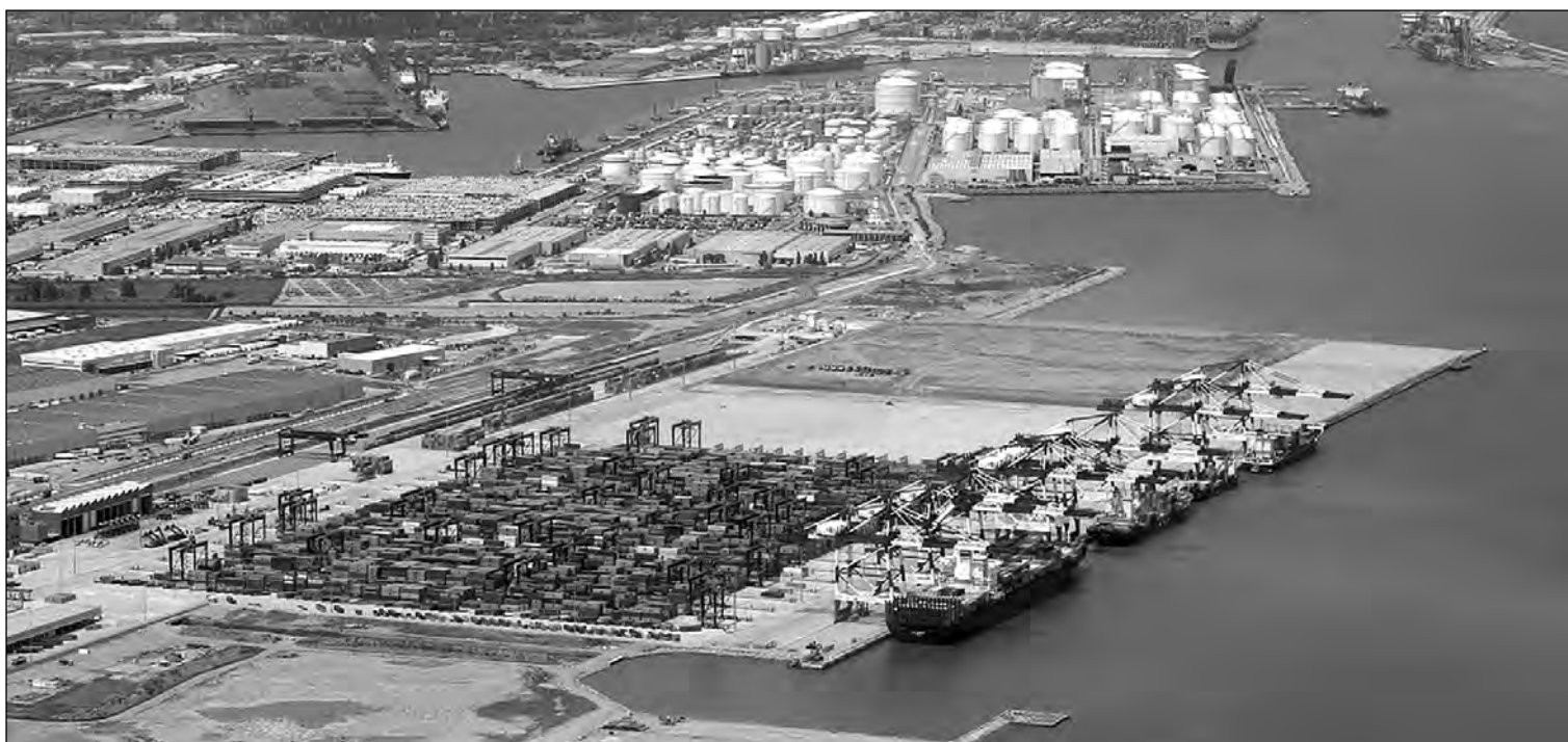
Con las nuevas obras, el puerto de Barcelona busca convertirse en un referente de conectividad e intermodalidad.
