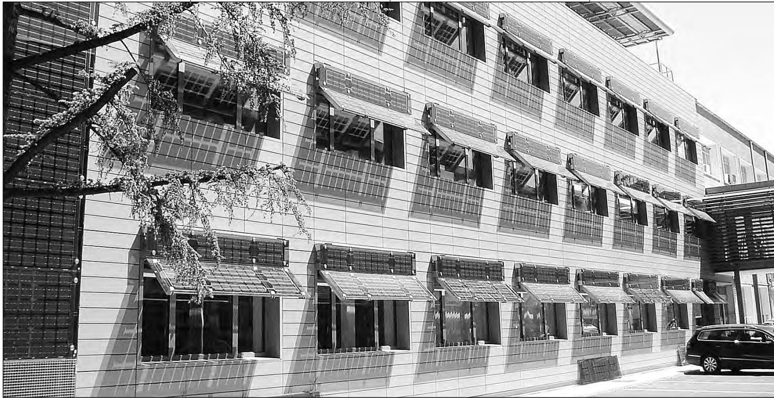
El Edificio 70 del Ciemat es bioclimático y cuenta con fachada ventilada de plaqueta cerámica y diferentes tipos y espesor de vidrio según la orientación.
