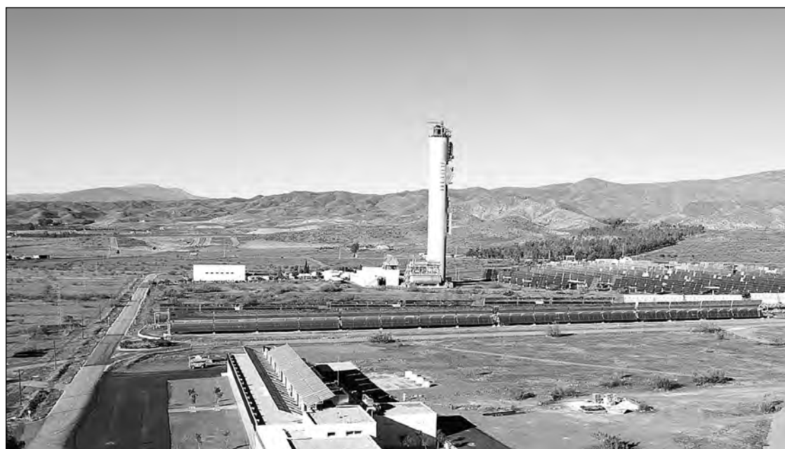
Entre los materiales utilizados en el C-Ddi de la Plataforma Solar de Almería predomina el mármol de Macael, el hormigón armado y el cemento. También se han empleado captadores solares y módulos fotovoltaicos integrados.
