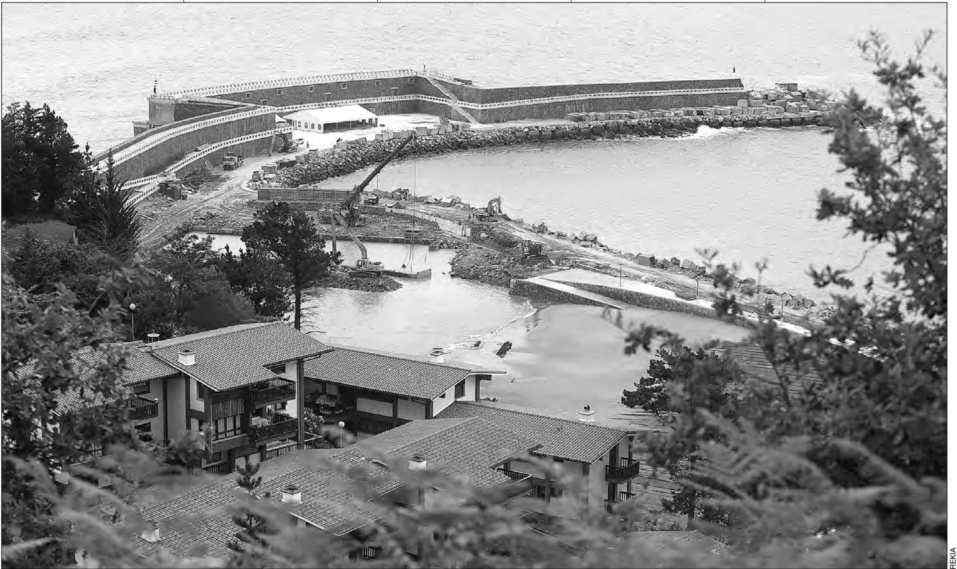
La planta de energía de las olas de Mutriku (Guipúzcoa) emplea la tecnología denominada de 'columna de agua oscilante'. La instalación, integrada en MaRINET, es la primera con configuración multiturbina del mundo. Tiene capacidad para 300 kW de potencia y ocupa cien metros de dique en el puerto de esta localidad.
